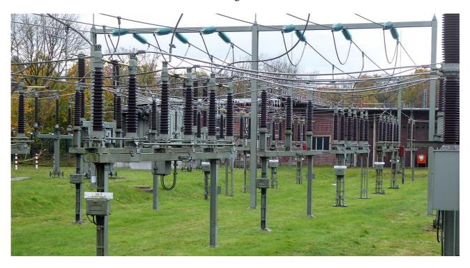
Kleines Feld in der Station Rheinpreussen. Zu erkennen sind geöffnete und geschlossene Trenner sowie einfache Stützisolatoren unter den beiden Sammelschienen.
