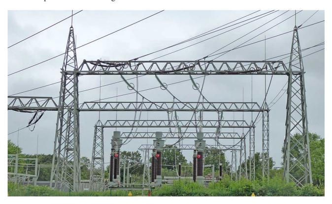
Eingangsportal mit Schaltfeld zum Trafo 220 kV auf 110 kV. Zur Überbrückung der Strecke sind mehrere Potale aufgestellt.
